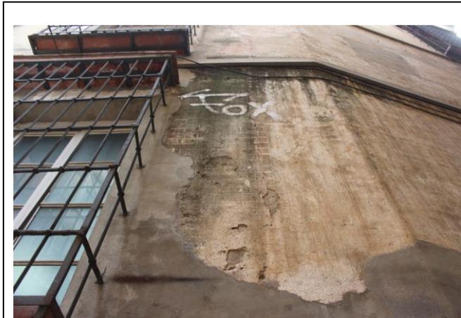
Reparaciones en el revestimiento realizadas con cemento
